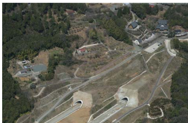
写真3 地すべり地帯に建設されたトンネル(地すべりとトンネルの安全監視にGPS変位計測システムを本格的に利用した事例)
